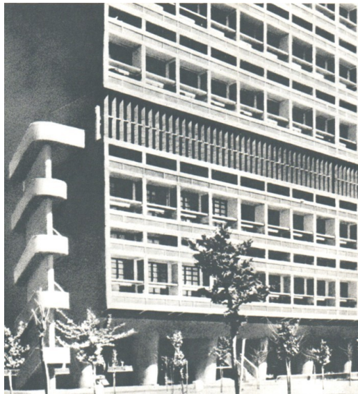
arch. Le Corbusier – Blok Marsylski 1947-1952
